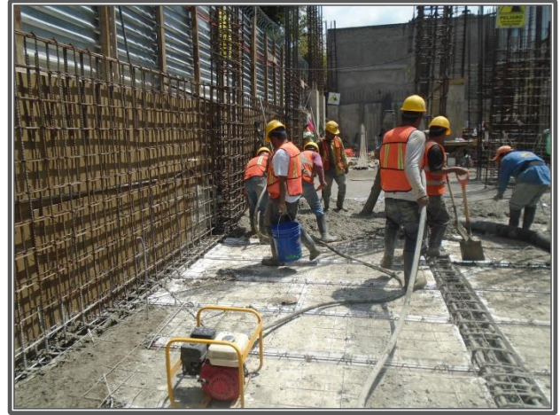
HABILITADO DE ACERO
