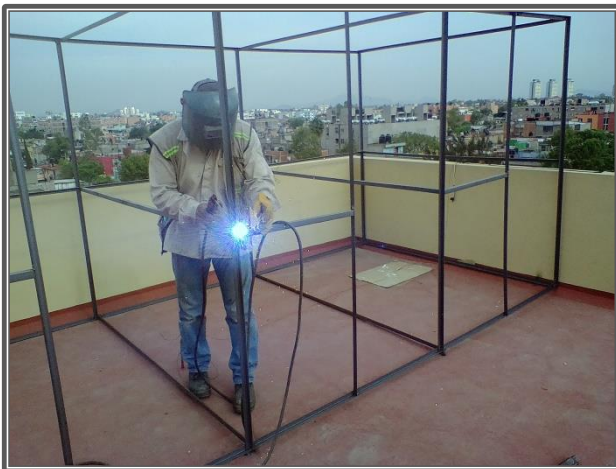
TRABAJOS DE HERRERÍA
