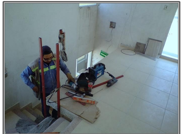
SUMINISTRO Y COLOCACIÓN DE HERRERIA
