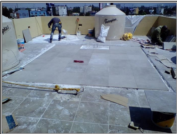
SUMINISTRO Y COLOCACIÓN DE PISO
