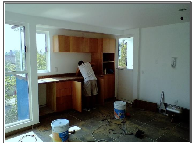
TRABAJOS Y SUMINISTRO DE CARPINTERIA
