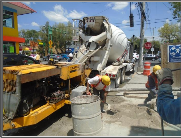
SUMINISTRO Y VACIADO DE CONCRETO
