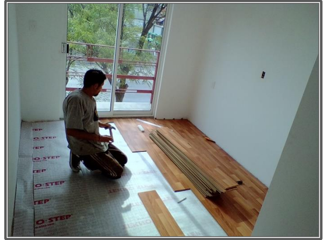
SUMINISTRO Y COLOCACIÓN DE LAMINADO
