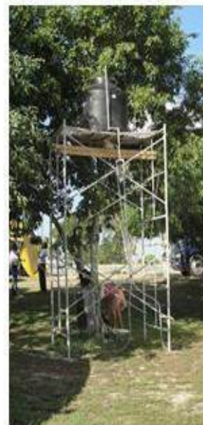
Instalación hidráulica por gravedad
