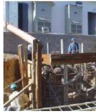
ELABORACION DE BASE PARA TORRE DE COMUNICACIONES
