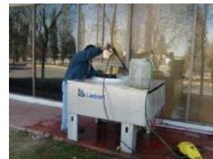
SERVICIO A CONDENSADORA DE EQUIPO DE PRECISION
