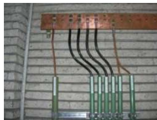
INSTALACION DE BARRAS DE COBRE
