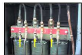
TRANSFORMADOR TIPO SECO
