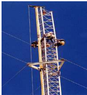
ARMADO DE TORRE
