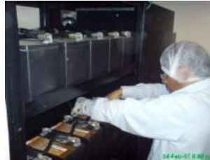
REEMPLAZO DE BATERIAS
