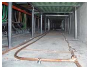
CABLE SOLDADO CON MOLDES Y SOLDADURA TIPO CADWELL
