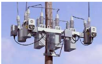
BANCO DE CAPACITORES TIPO POSTE PARA SISTEMA DE 13.8 Kv
