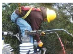
LIMPIEZA DE AISLADORES
