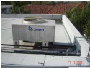
CONDENSADORA DE EQUIPO DE PRECISION
