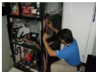
MANTENIMIENTO A EQUIPO DE 5 TON. REFRIGERACION
