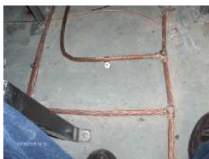
CABLE SOLDADO CON MOLDES Y SOLDADURA TIPO CADWELL
