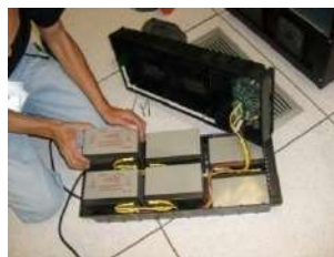
REEMPLAZO DE BATERIAS
