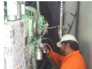
APLICACIÓN DE PINTURA
