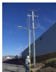
APERTURA DE CUCHILLAS AEREAS EN MEDIA TENSION
