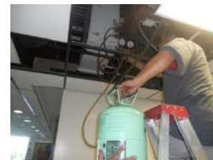
CARGA DE GAS TIPO R - 22 A EQUIPO MINISPLIT
