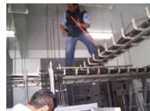
LIMPIEZA DE CABLEADO Y CHAROLAS
