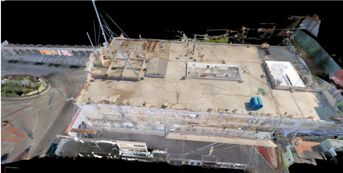
Ilustración 2. Levantamiento con nube de puntos y modelado as-built Ayuntamiento de Manzanillo 11,905 m 2 , Colima 2026
