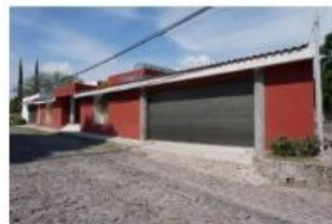
FACHADA A LA CALLE VISTA DESDE EL SUROESTE
