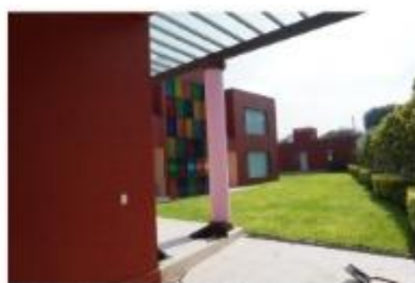
FACHADA INTERIOR VISTA DESDE EL OESTE EN COCHERA
