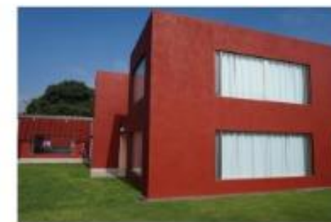
FACHADA INTERIOR VISTA DESDE EL ESTE DEL JARDÍN
