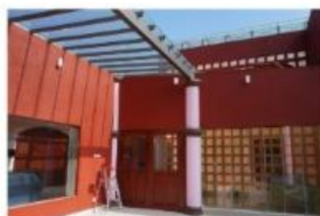
FACHADA INTERIOR VISTA DESDE SUR OESTE DEL JARDÍN VIENDO CANTINA Y TERRAZA
