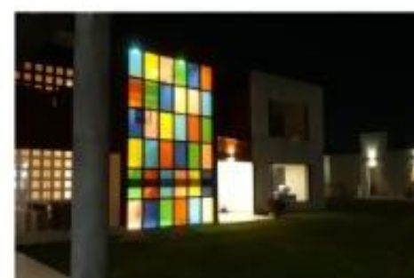
VISTA NOCTURNA DE FACHADA AL JARDÍN DE ESCALERAS
