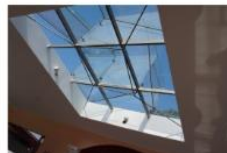
ACERCAMIENTO DE DOMO DE CRISTAL VISTA INTERIOR HALL DE DISTRIBUCIÓN
