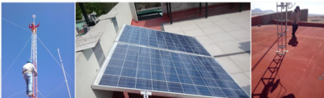
En Junio del 2015, BeTechnology nos subcontrata para realizar la instalación de una torre meteorológica de 10 m y una base para estación solarimétrica en Tepic, el estado de Nayarit, como parte de un contrato que nuestro cliente tenía con la Universidad autónoma de Nayarit.
