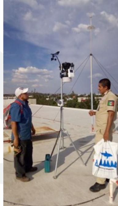
En septiembre del 2019 se realizó la instalación de pluviómetros WXT531 Vaisala en 5 estaciones de la Comisión Estatal de Aguas de Querétaro dentro del mismo estado, con la conexión a datalogger waterlog con transmisión satelital GOES.
