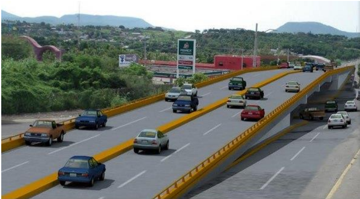
Proyecto Puente Superior ubicado en la Av. Álvaro Obregón y México 68 Culiacán, Sinaloa.
