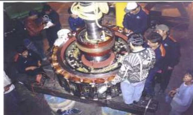
CONCLUYE FABRICACION DE POLOS PRINCIPALES TIPO CERCHA; SE REALIZA INSTALACION Y CONEXIÓN DEL PUENTE RECTIFICADOR
