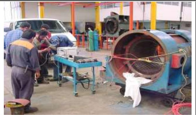
PERSONAL DE CFE-LAPEM, REALIZA PRUEBAS: EL CID, A ESTATOR DE
