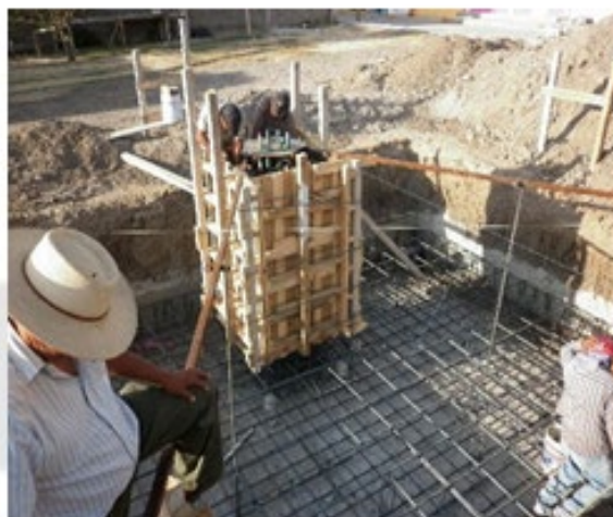
CONSTRUCCION DE SITO PARA TELEFONIA CELULAR
