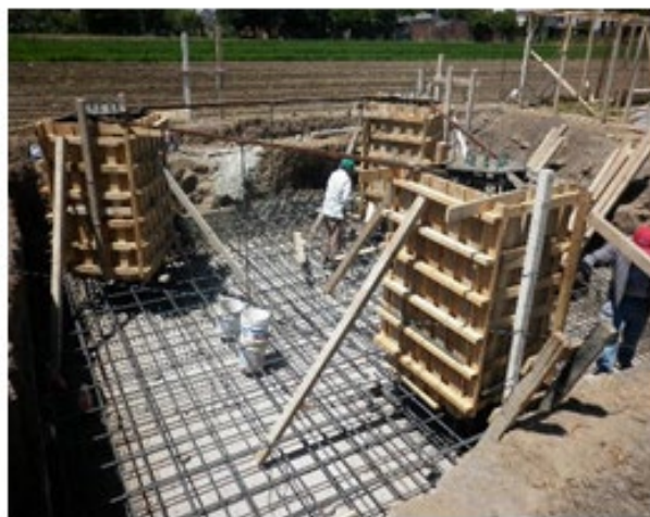
CONSTRUCCION DE SITO PARA TELEFONIA CELULAR
