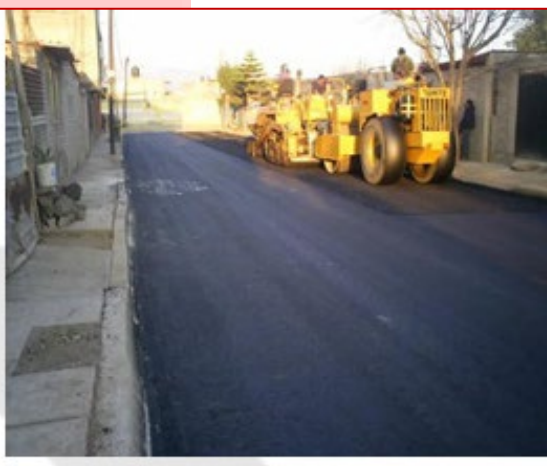
PAVIMENTACIÓN DE CALLES CON CARPETA ASFALTICA
