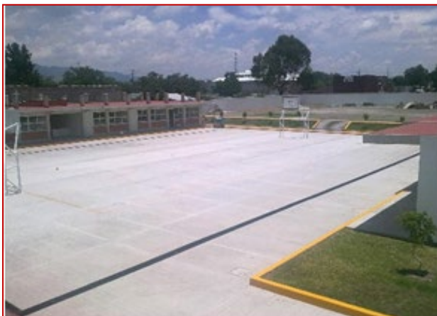
CONSTRUCCIÓN DE ESCUELA PRIMARIA EN HUEHUETOCA, EDO. DE MÉXICO
