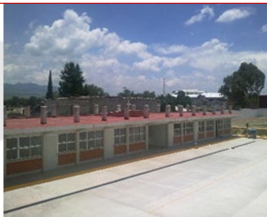
CONSTRUCCIÓN DE ESCUELA PRIMARIA EN HUEHUETOCA, EDO. DE MÉXICO
