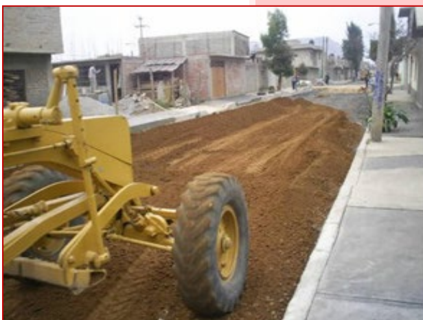
PAVIMENTACIÓN DE CALLES CON CARPETA ASFALTICA
