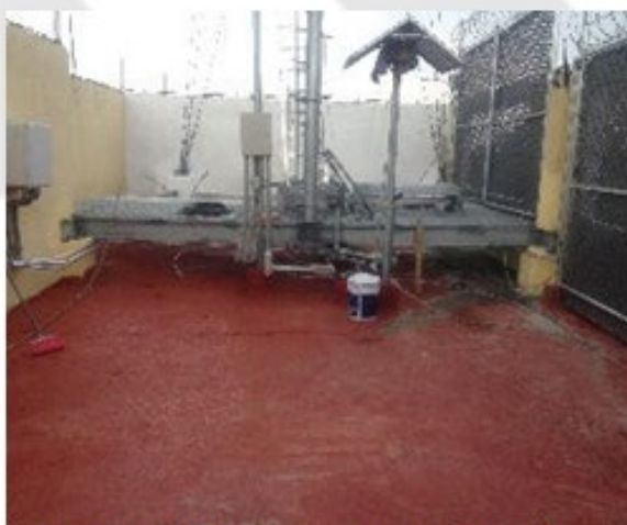
SITIO LOMAS DE PADIERNA, MÉXICO D.F... CONSTRUCCION DE SITIO CON TORRE MINIPOLO EN AZOTEA
