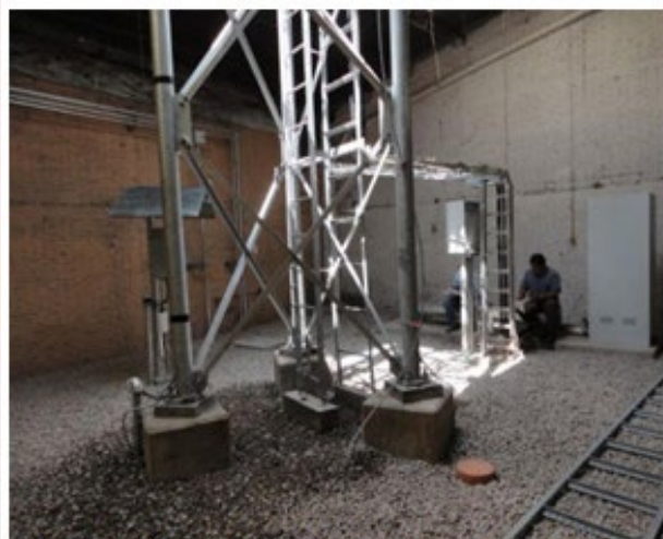
SITIO PINTORES, NAUCALPAN, EDO. MEXICO... CONSTRUCCIÓN DE SITIO CON TORRE RAW- LAND EN PISO
