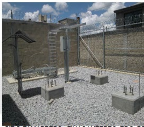
SITIO ZAMARRERO, ZINACANTEPEC, EDO. DE MÉXICO... CONSTRUCCIÓN DE SITIO CON TORRE LAW- LAND EN PISO
