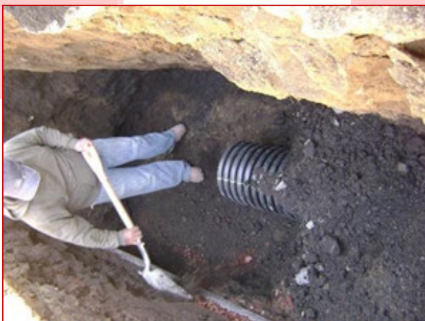
TRABAJOS DE REDES GENERALES DE DRENAJE
